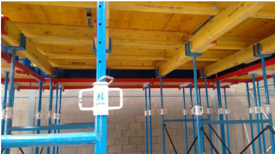
Detalle montaje Sistema Encofrado Rapido
